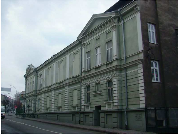
1/ Widok elewacji południowej.
