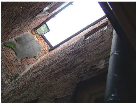
3/ Studnia w części północnej.
