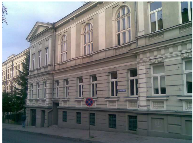
3/ Widok elewacji zachodniej.
